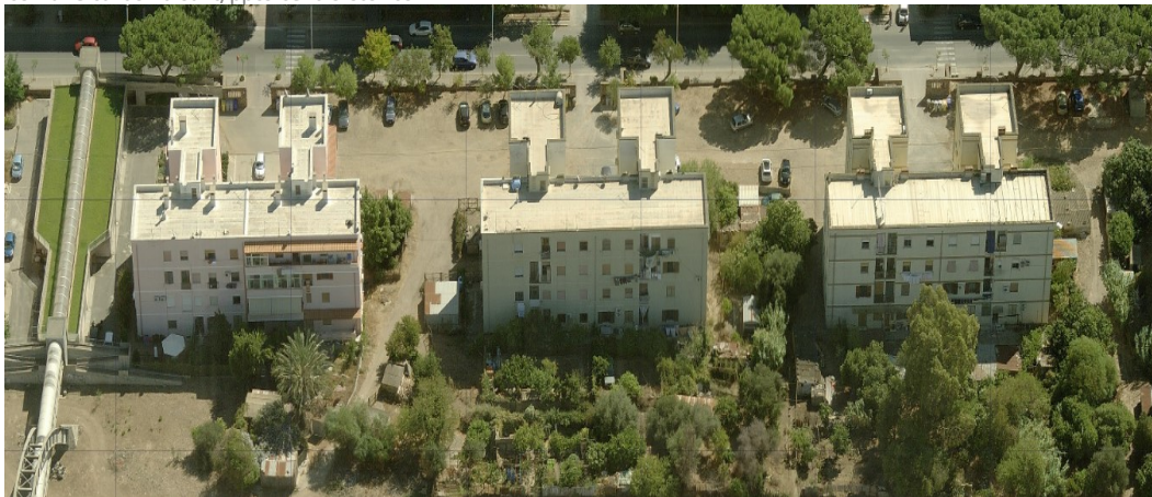
Figura: foto obliqua di alcuni edifici O/5 , fonte http://www.sardegnaegeoportale.it/webgis2/sardegnafotoaeree/
